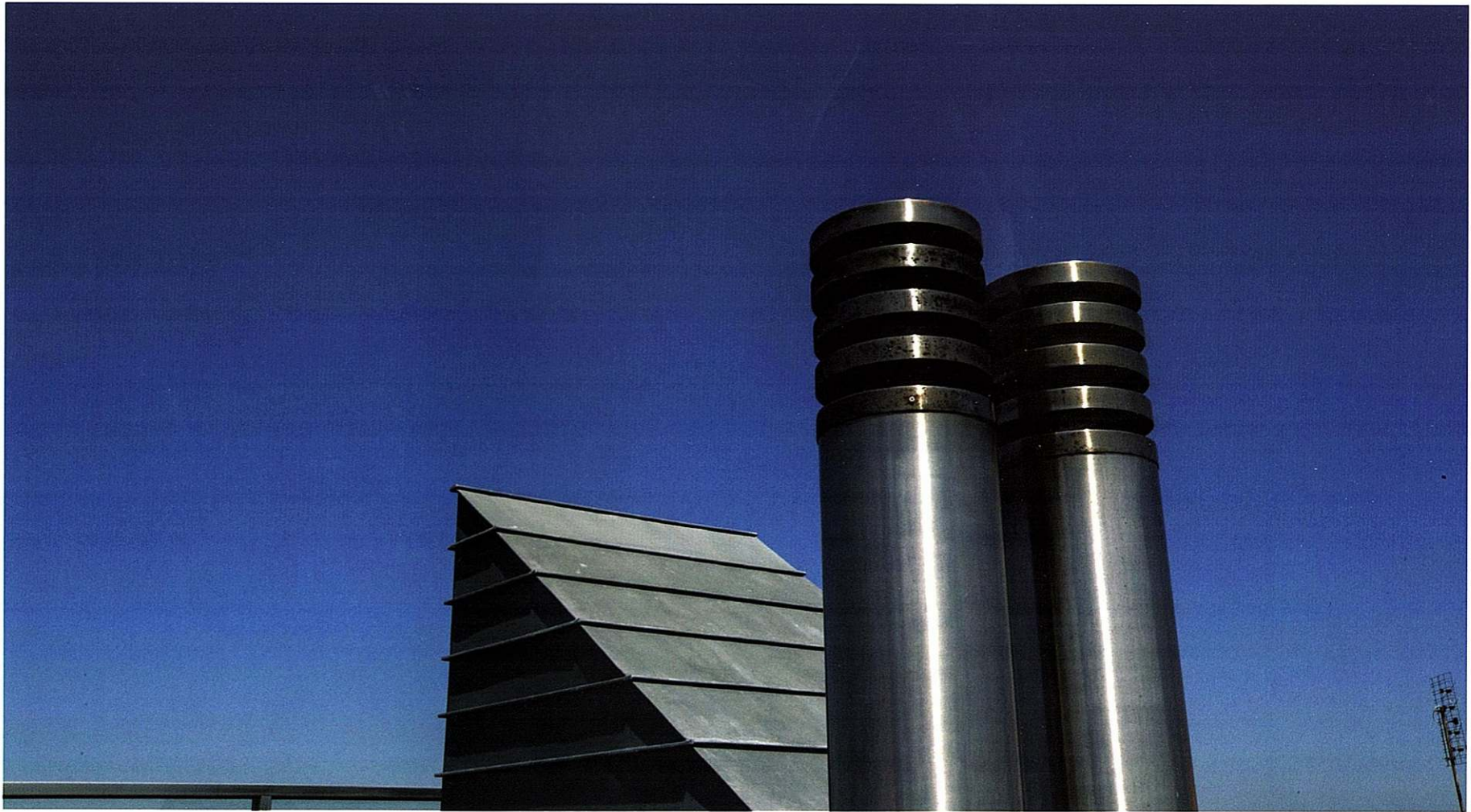
Designação Habitação VA Local Torreira - Murtosa Arquitectura José António Lopes da Costa; Tiago Meireles Colaboradores Joana Jorge Especialidades VELNOR Data do Projecto 2008-2009 Data da Obra 2011-2013 Fotografias Manuel Aguiar
