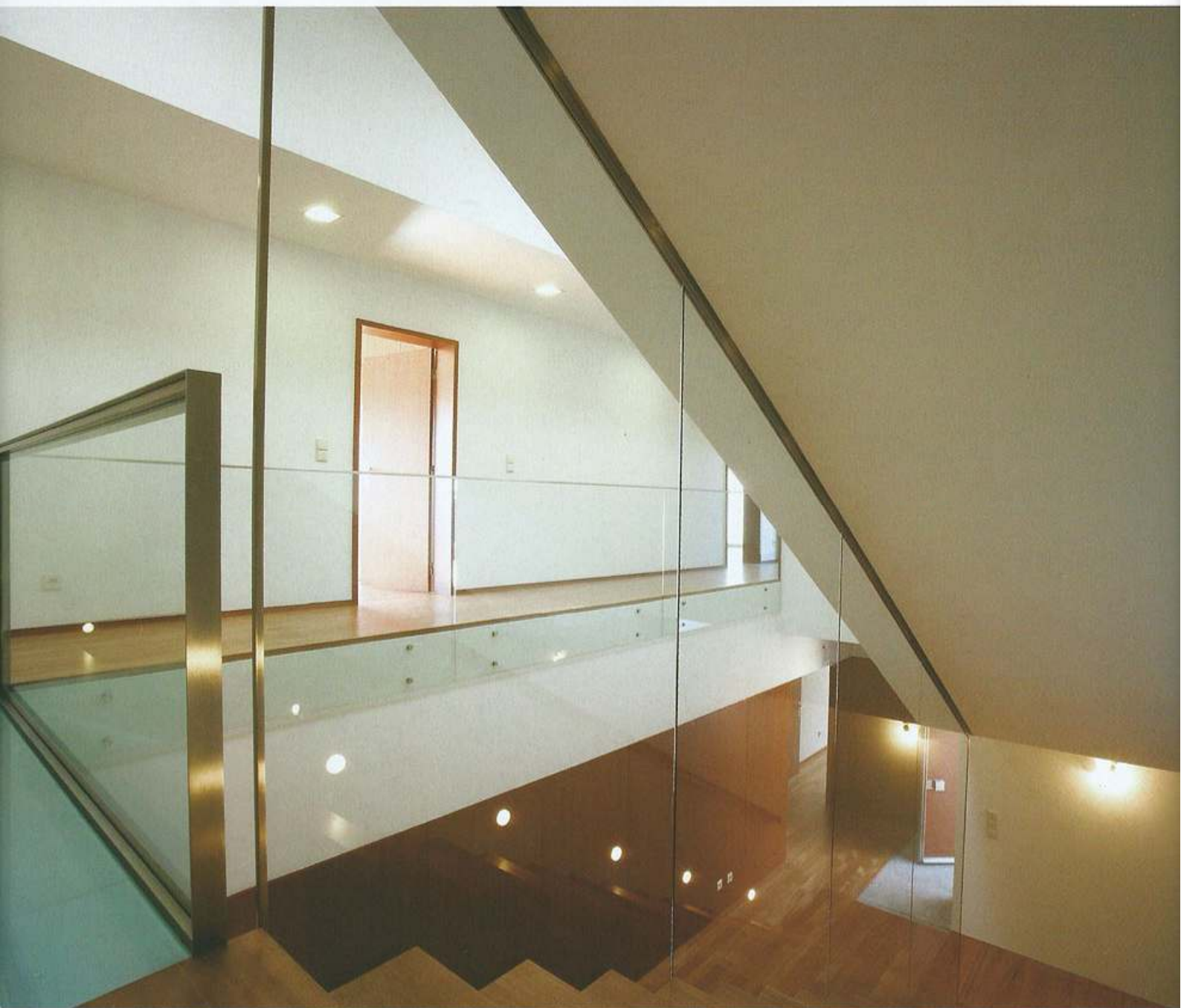
➤ O interior surge sublinhado pelo corredor de distribuição e pela impressionante ponte que liga a escada ao corredor, com pavimento em vidro
